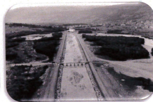
Endiguement de l'Arve à Sallanches
