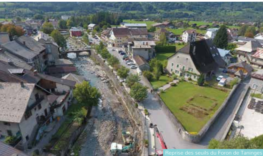
Reprise des seuils du Foron de Talinges
