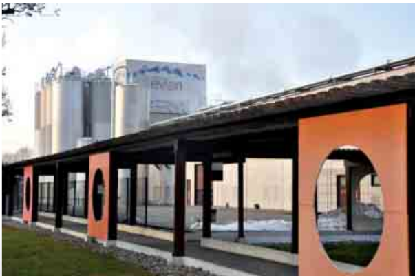
Sortie des anciens - Usine des eaux d'Evian
