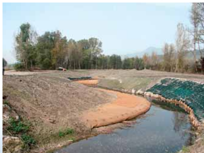
Nant de Sion reméandré après travaux
